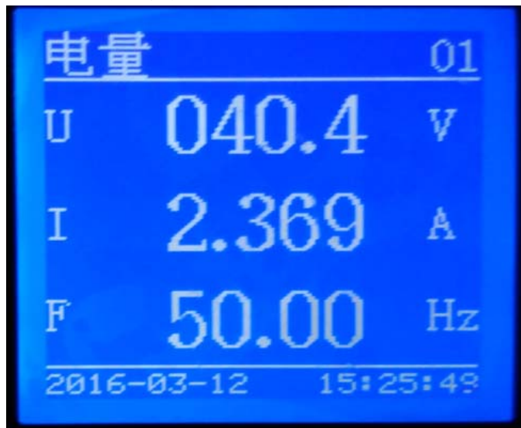
图 4-4 电量监测仪显示电压、电流参考大小
